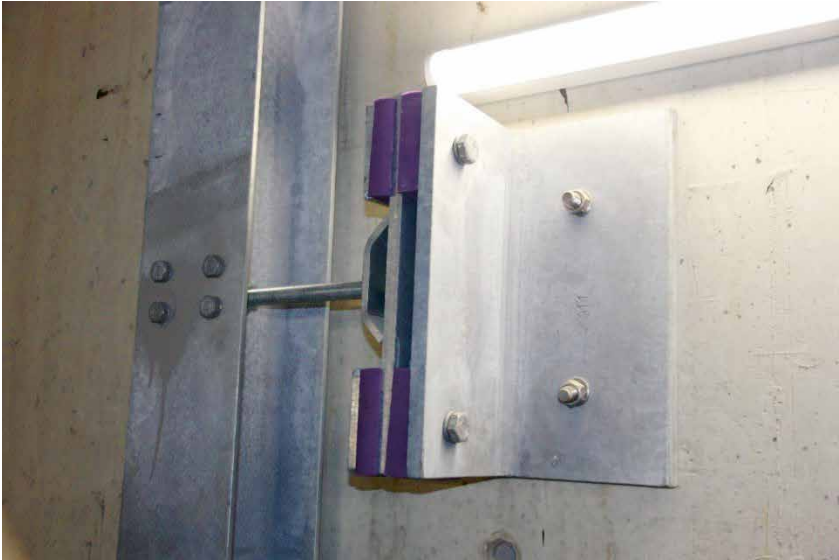
Bild 18: Beispiel für die Körperschall-entkoppelte Installation im Bauwerk
