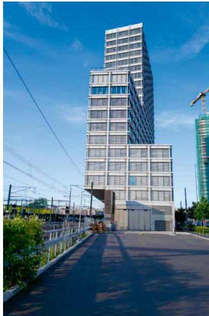
Bild 1: Südwestseite des Franklinturms mit der Zufahrt zum automatischen Parksystem direkt am Ladehof; links befindet sich die Bahntrasse, rechts die Hofwiesenstraße
